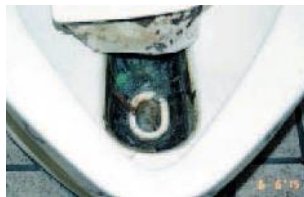
3ヶ月後 尿石が軟化して 剥離している
